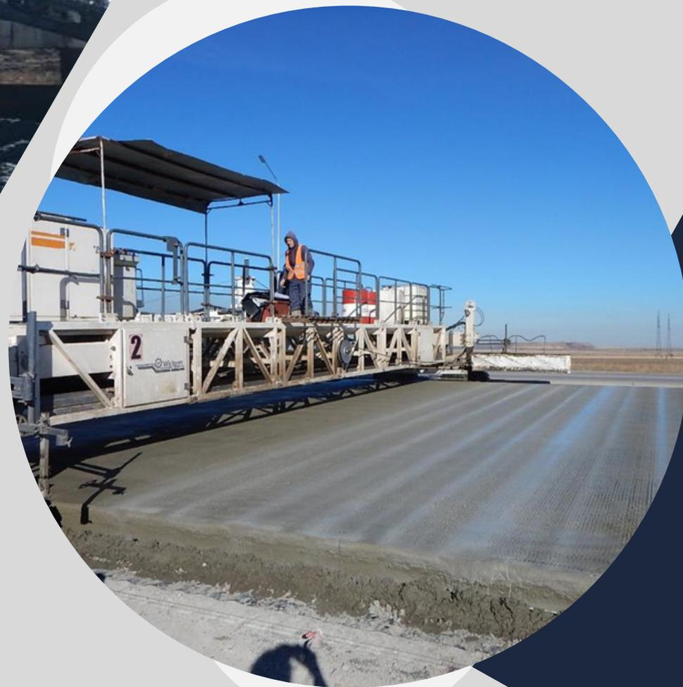
Экономичная бетонная укладка с шириной захвата от 5,0 до 16,0 м. Различная толщина укладки до 450 мм в стандартной комплектации.
